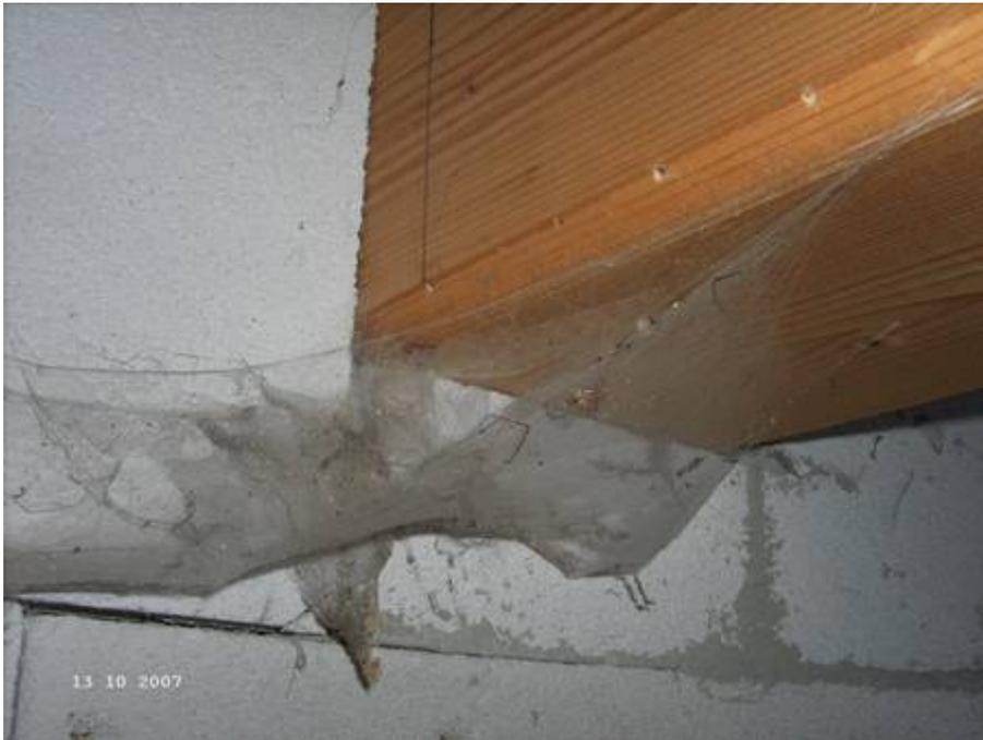
Befall mit Nagekäfern an einer Brettschichtholzpfette im Dach eines Freisitzes. Technisch getrocknetes Holz ist unter Bedingungen der GK 1 befallen worden. Es ist nicht zu erwarten, dass der Befall kurzfristig abklingt. Bis es zu einer Gefährdung der Standsicherheit kommt muss der Befall noch lange fort dauern. Dennoch ist davon auszugehen, dass der Besteller einer Konstruktion nicht erwartet, dass bereits kurz nach deren Erstellung ein Insektenbefall eintritt.
