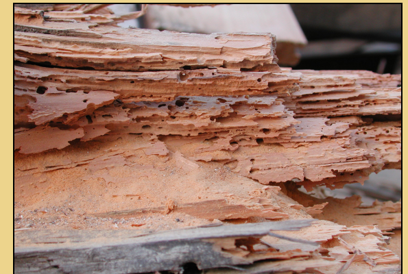
Bunter Nagekäfer nach vorangegangenem Pilzbefall an einem Fichtenbalken.
