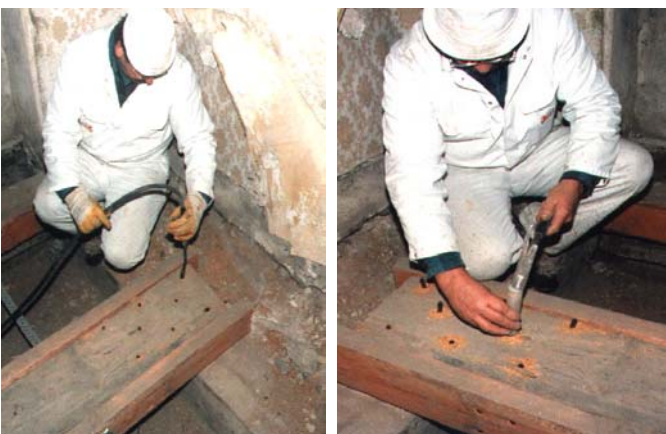
Bild 2: Bohrlochdrucktränkung
