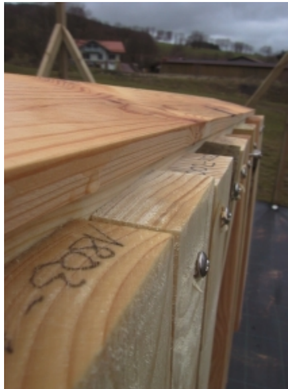
Abbildung 7: Wie nebenstehend, jedoch nicht geschützt, d.h. ohne Hirnholzabdeckung
